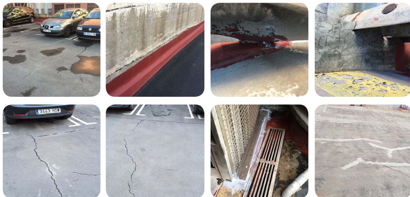
Rehabilitación Parking Comunidad Propietarios C/Floridablanca, 86 - Barcelona
